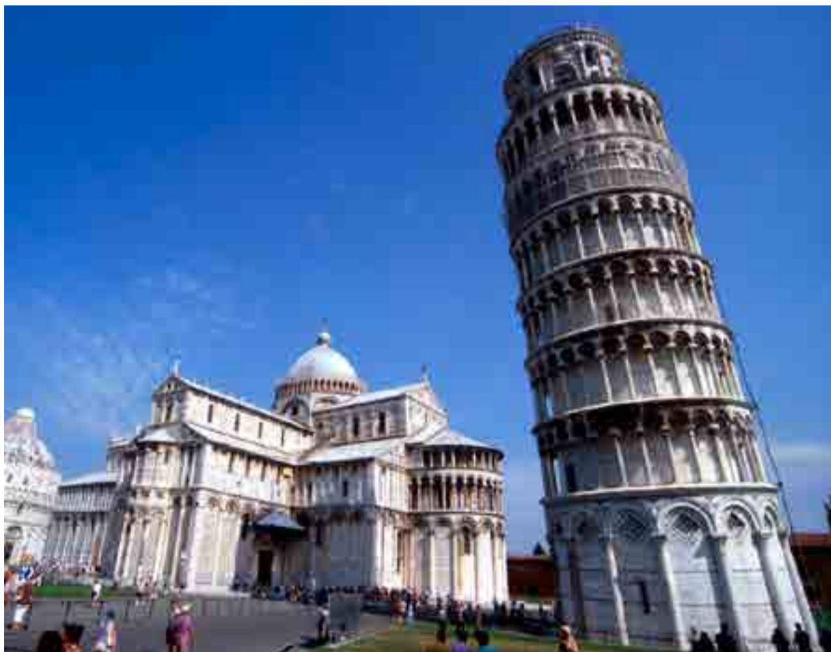
Con siete siglos, el célebre edificio resiste el paso del tiempo pese a su riesgosa inclinación.
