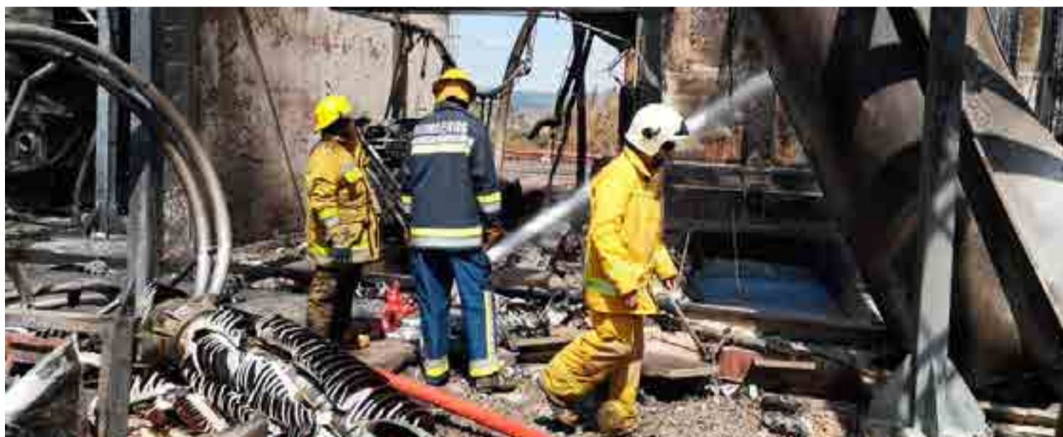
Así quedó el patio de transformadores de la Central Hidroeléctrica de El Guri luego del ataque.
